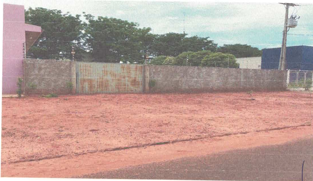
FOTO 02 - VISTA EXTERNA DO LOTE 001/H.
